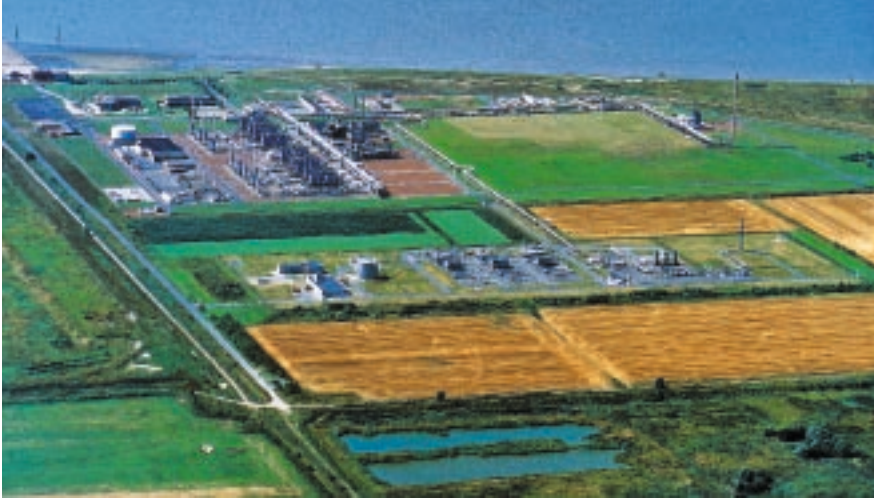
Das Gassco-Terminal am Rysumer Nacken bei Emden. Foto: Gassco
