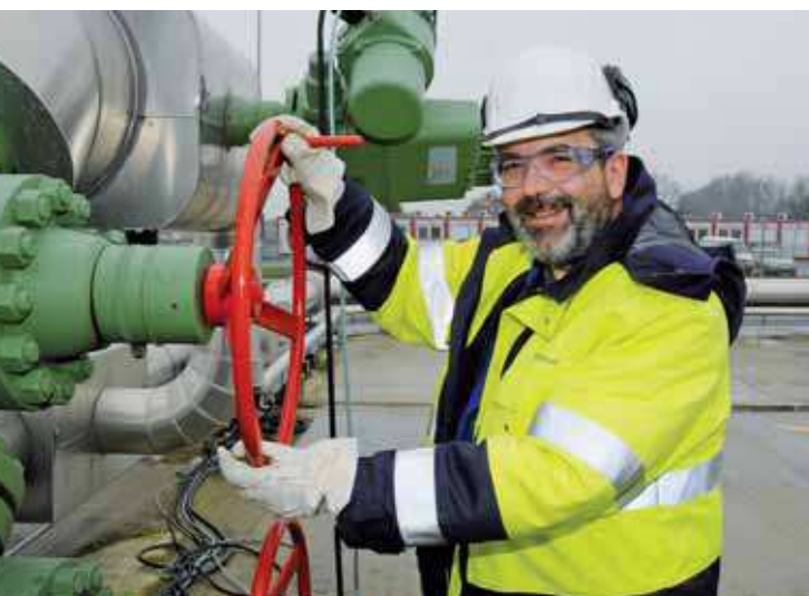
Wolfgang Schöbel kümmert sich um die Wartung des Energiespeichers in Etzel. Foto: IHK
